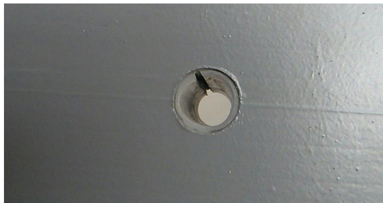
شکل (۱۷) - نمونه بوشینگ مقاوم در برابر گشتاور
